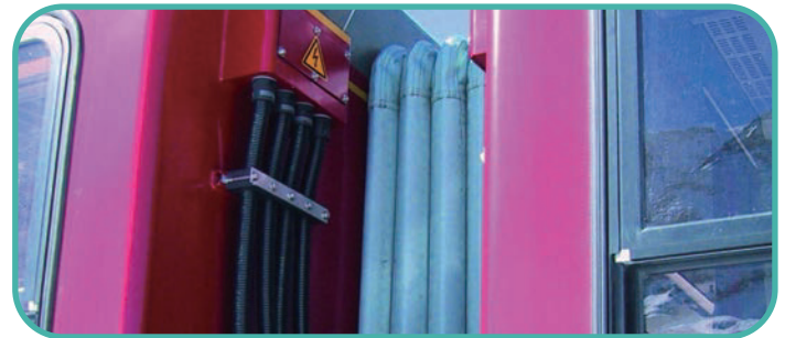
External installation 外部安装
